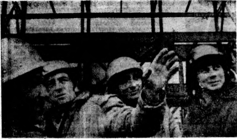
Комсомольско-молодежная бригада В. Волошина «Южстальконструкция» ведет монтаж главного корпуса Атоммаша. Молодые монтажники с большой ответственностью относятся к своей работе. На снимке: бригадир В. ВОЛОШИН (второй слева) с молодыми монтажниками. Фото В. Яшина.
